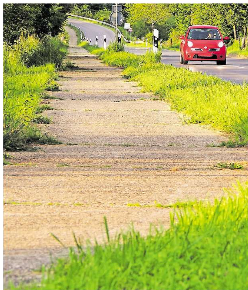
Mehr Komfort und Sicherheit verspricht der Asphalt des neuen Radwegs, der die alte Betonpiste ersetzen soll. FOTO: JÜRGEN LANGE
