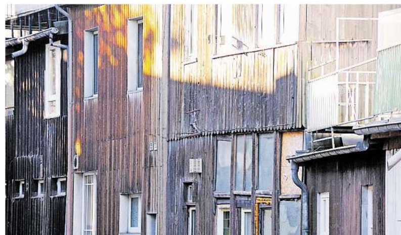
Romantisch oder schäbig? Neue Einblicke gibt es – in Richtung Burgstraße – auch auf die historische Hinterhoflandschaft am Vichtbach.
