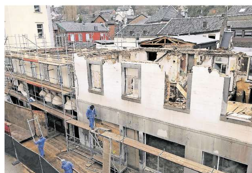
Die Dächer sind weg: Die Arbeiten im Steinweg gehen in diesen Tagen weiter voran.
