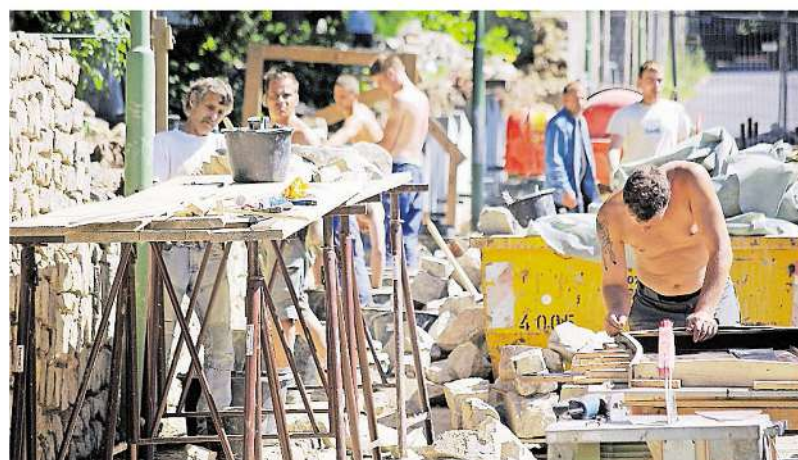
Im Rahmen einer Qualifizierungsmaßnahme für Jugendliche und Langzeitarbeitslose ließ die Stadt im Sommer 2008 die Mauer des Friedhofs Bergstraße am Halsbrech erneuern.
