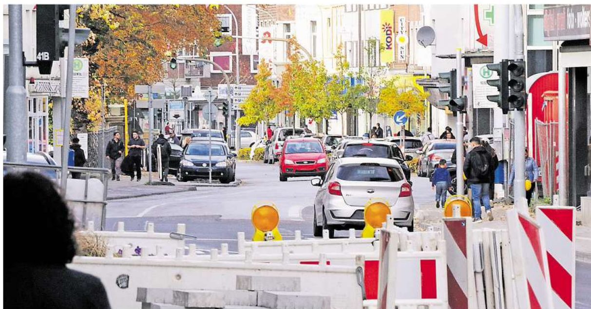
Wenn am 29./30. November die Arbeiten an der oberen Rathausstraße enden, beginnt der dritte Bauabschnitt der Neugestaltung zwischen Schellerweg und Stadthalle.
