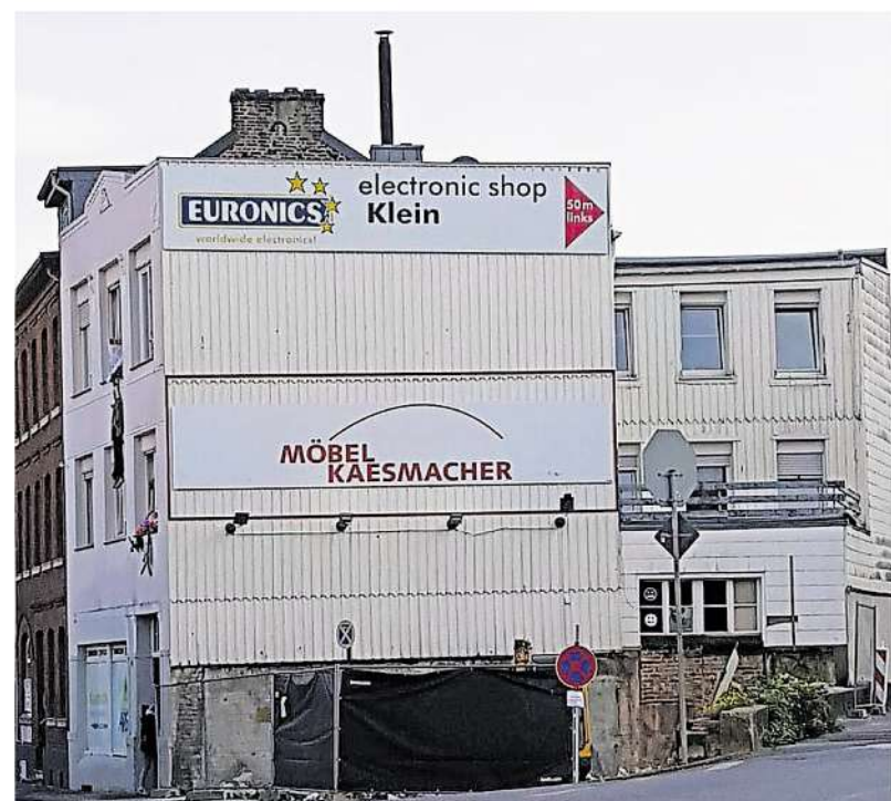
Die Garagen in der Stielsgasse wurden bereits abgerissen. Dort soll ein grünes Entrée entstehen.
