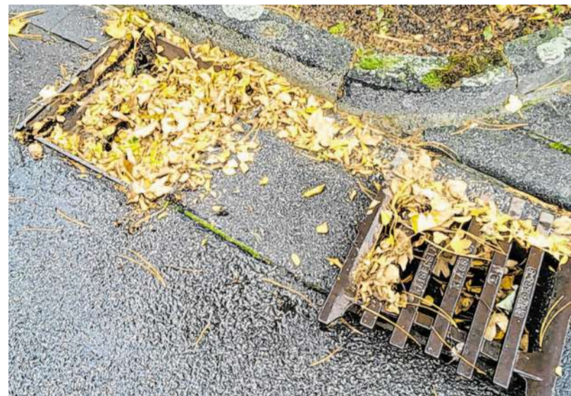
Unter dem Gullydeckel sammelt sich im Herbst besonders viel der abgefallenen Blätter. Die Schlitzzeimer darin werden regelmäßig gesäubert.
