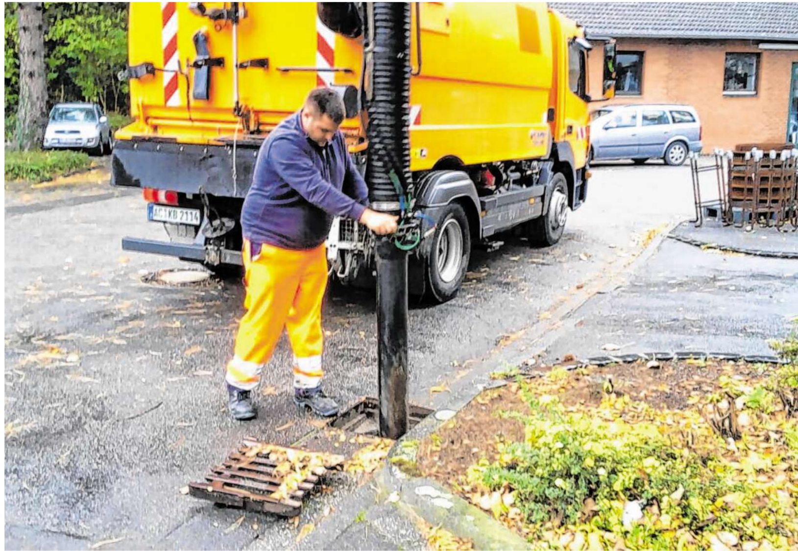
Mitarbeiter Christian Dümont des Kanalbetriebshofs säubert mit Hilfe einer Saugmaschine den Gully. Neben Laub findet sich dort oft auch Hundekot, den die Bürger dort beseitigen. Fotos: Vivien Nogaj
