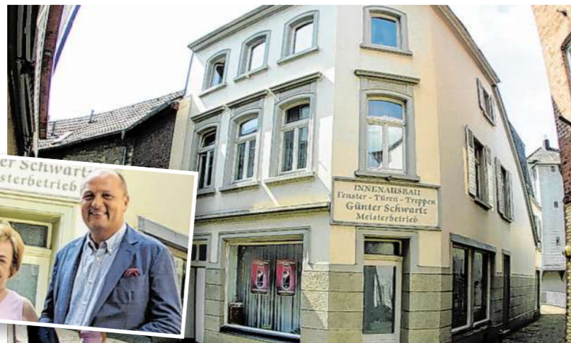
Axel und seine Mutter Elisabeth Schwartz lassen sich städtischer Unterstützung die Fassade ihres Hauses an der Klatterstraße sanieren.
