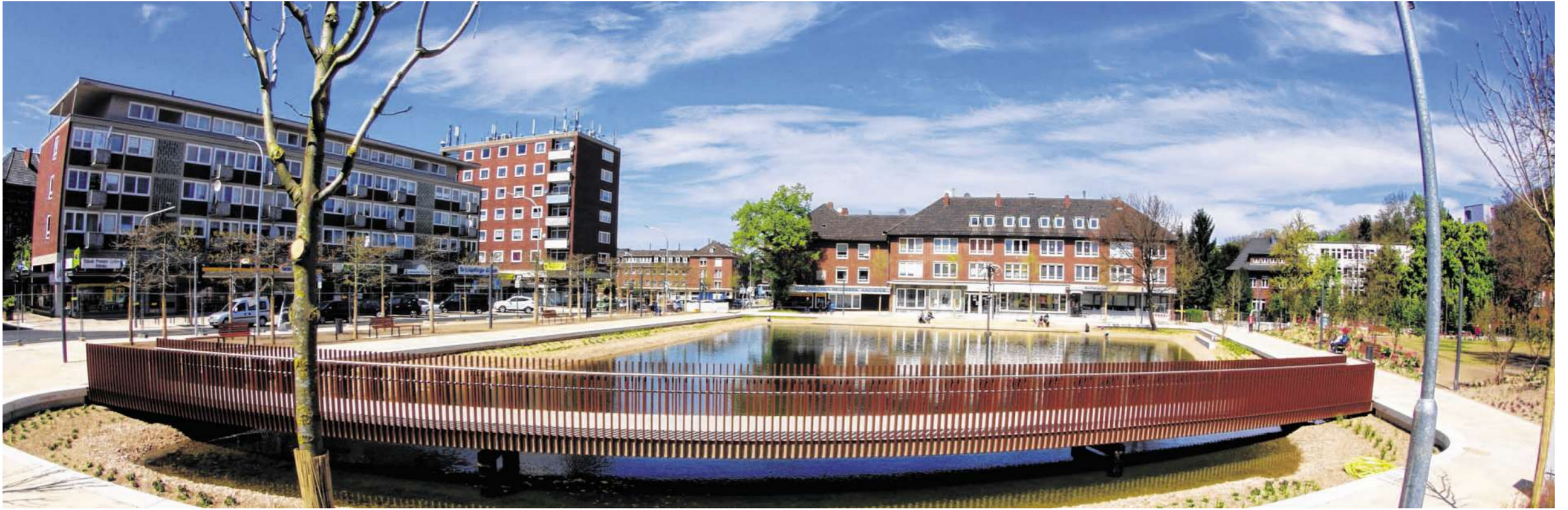
Wird am Samstag offiziell den Bürgern übergeben: der modernisierte Bastinsweiher in der Stolberger Innenstadt. Ruhebänke laden zum Verweilen in der Sonne ein. Und die neue Brücke soll für einen Blick ins Wasser und auf die Fische sorgen. Foto: J. Lange
