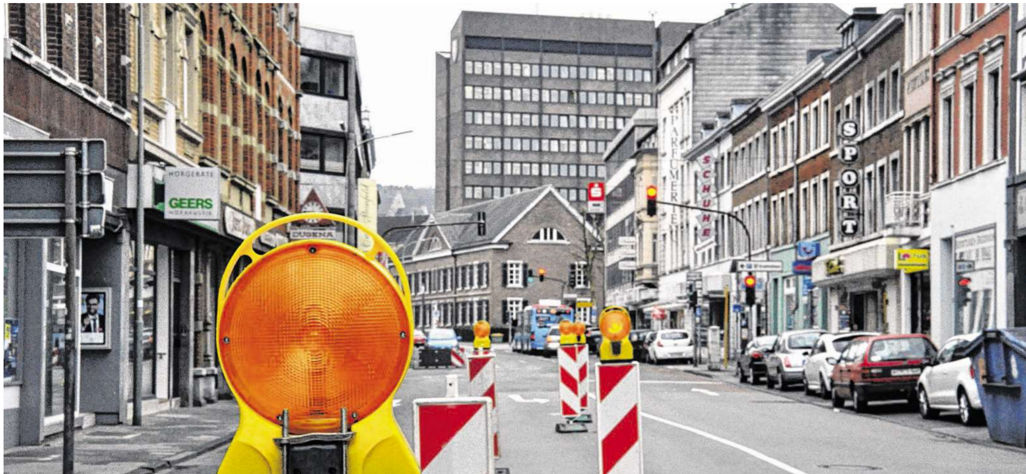
In einem knappen Monat beginnt die Sanierung der Stolberger Rathausstraße. In einem ersten Abschnitt wird das Straßenstück vom Kaiserplatz aus in Richtung Schellerweg saniert. Für die kleinteilige Baustellenplanung hat sich die Stadtverwaltung entschieden, um die Situation für Anwohner und Geschäftsleute erträglich zu halten. Fotos: S.-L. Gombert
