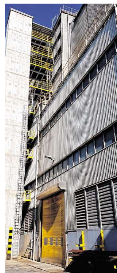
Bis in 36 Meter Höhe führt der neue Aufzug in die Betriebshalle des QSL-Reaktors der Bleihütte Binsfeldhammer. Foto: Berzelius
