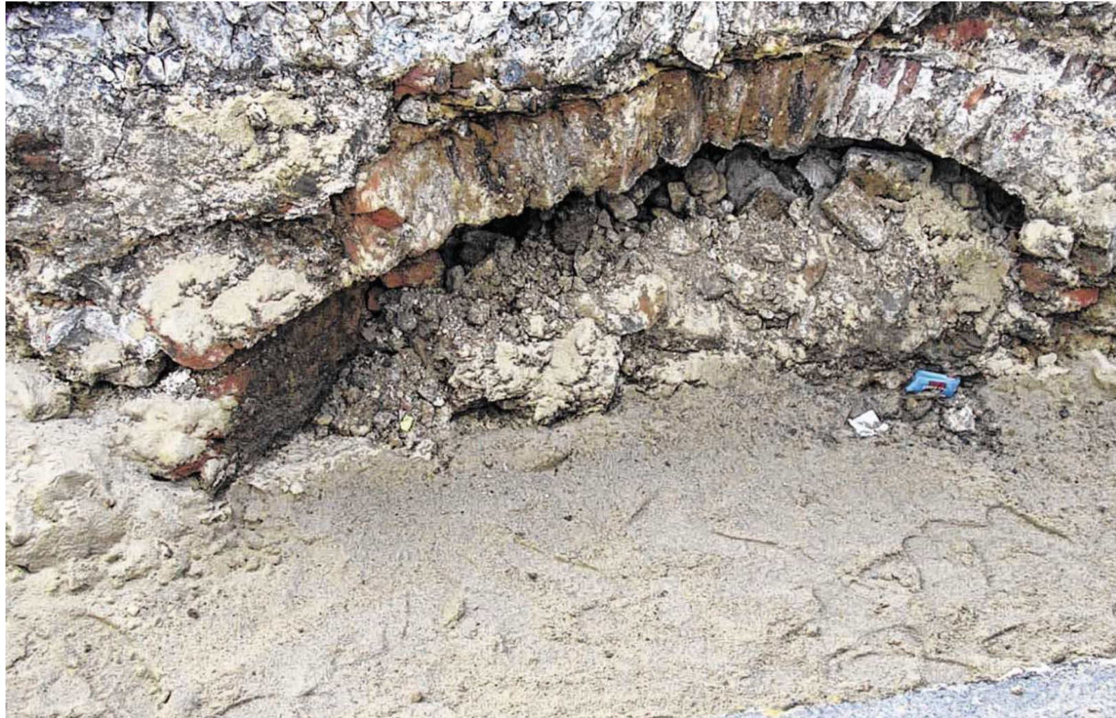
Ein Highlight für Historiker, aber eher die Hölle für Bauingenieure: Solche Gewölbe früherer Industrie wurden reihenweise in der Rathausstraße gefunden, mussten aber aufwendig und kostenintensiv verfüllt werden. Foto: T. Dörlinger
