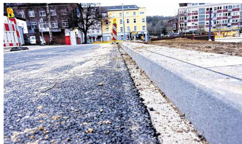
Mehrleistung, die nicht zum Entwicklungskonzept gehört: Die Hälfte der Straße „Am Bastinsweiher“ wurde erneuert. Foto: J. Lange
