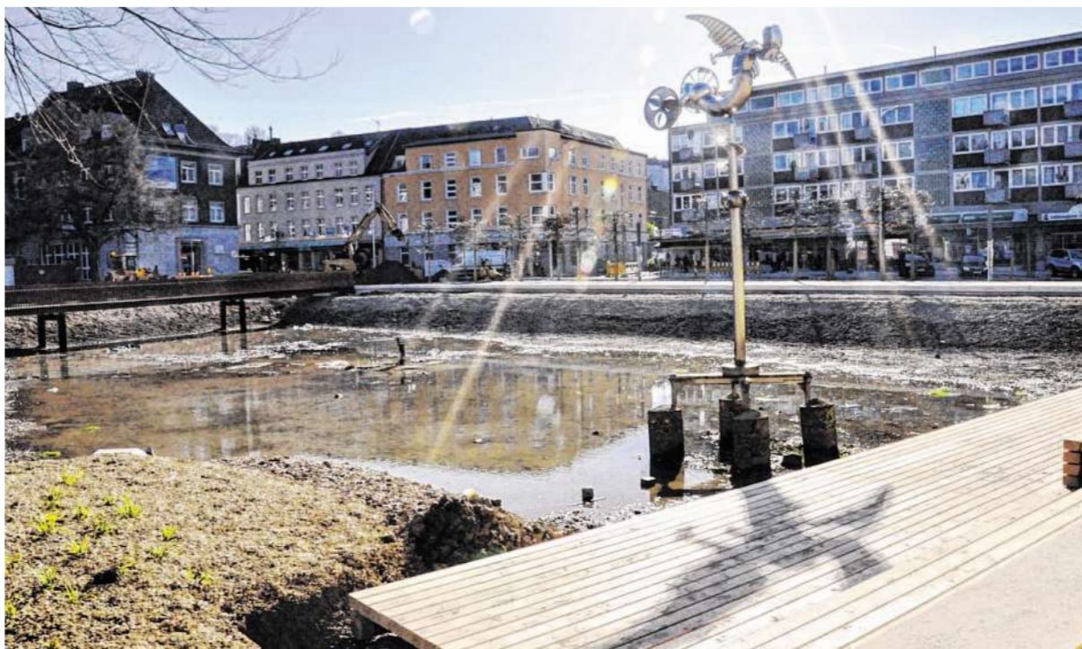
Langsam aber sicher nimmt der neugestaltete Bastinsweiher an der Stolberger Rathausstraße Gestalt an. Nach der Fußgängerbrücke wurde jetzt die Holzterrasse angebracht. Foto: S.-L. Gombert
