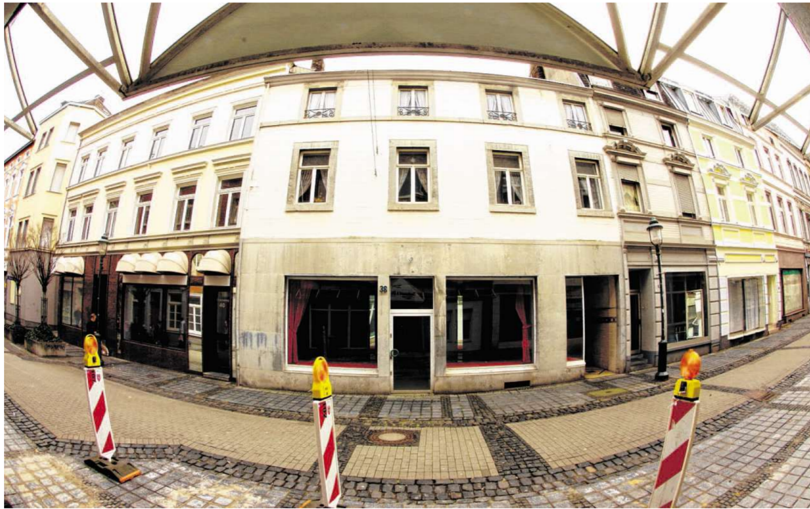
Alleine im Steinweg stehen 37 Häuser unter Denkmalschutz, nicht aber die Häuser 40 und 38. Auch deshalb sind sie für einen Abriss zugunsten eines Quartiersplatzes ausgewählt worden. Jetzt beantragt das Amt für Denkmalpflege die Unterschutzstellung von Haus Nr. 38. Fotos: J. Lange
