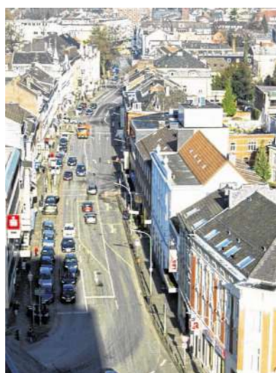
Am 2. Mai beginnt am Fuße des Rathauses die Umgestaltung der Innenstadtachse. Foto: J. Lange
