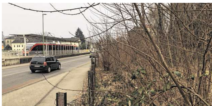
Auf dem ehemalige Vegla-Grundstück an der Ecke von Eisenbahnstraße und Schneidmühle soll eine weitere P+R-Anlage entstehen. Foto: (-)jül-
