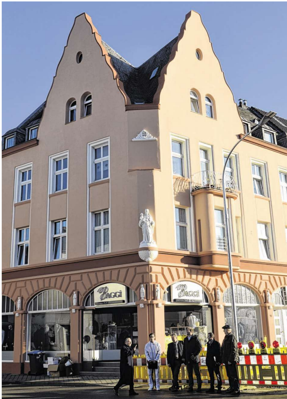
Ein erstes Beispiel für Städtebauförderung für private Investitionen: Die frisch sanierte Fassade des Gebäudes Rathausstraße 98 wertet das Umfeld wie die Immobilie auf. Foto: D. Müller
