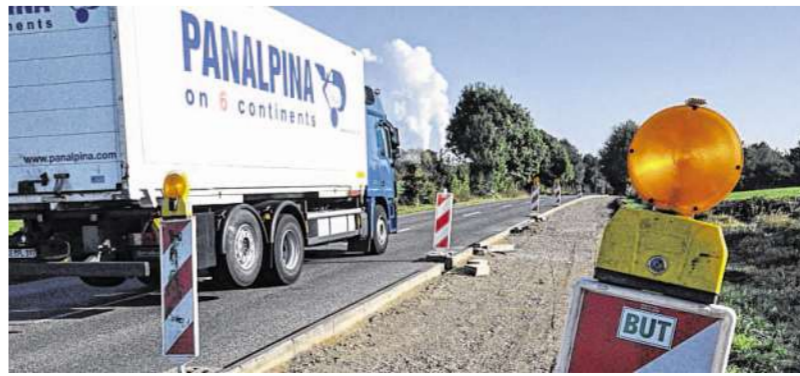
Zunächst saniert die Städteregion den Radweg zwischen Donnerberg und Hastenrath. Danach wird die Fahrbahn erneuert. Foto: S.-L. Gombert
