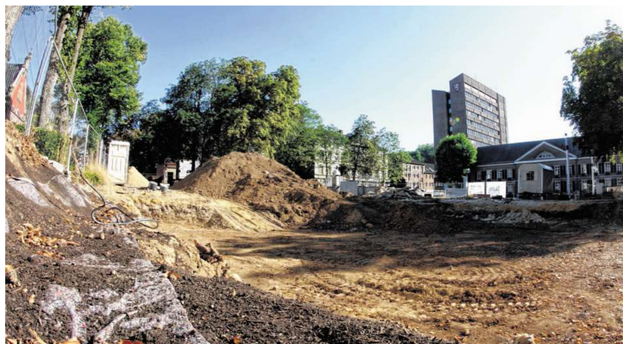
Es geht weiter unterm Kaiserplatz: Das Auskoffern für den Keller des Kupferpavillons wird wieder aufgenommen. In vier Wochen wird der Keller aus Fertigteilen geliefert. Foto: J. Lange
