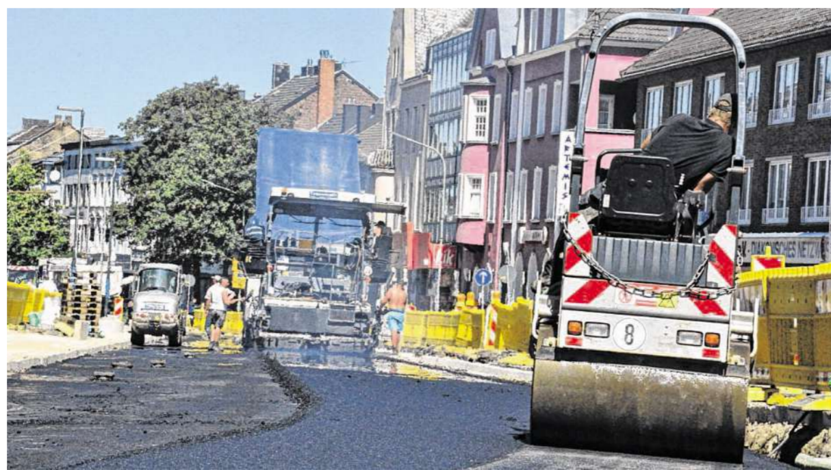
Die Tragschicht der neuen Rathausstraße von Frankental- und Jordanstraße bis hin zur Talbahnstraße wird gefahren. Heute wird sie in Betrieb genommen. Nun folgt der Ausbau der Uferpromenade. Foto: S.-L. Gombert
