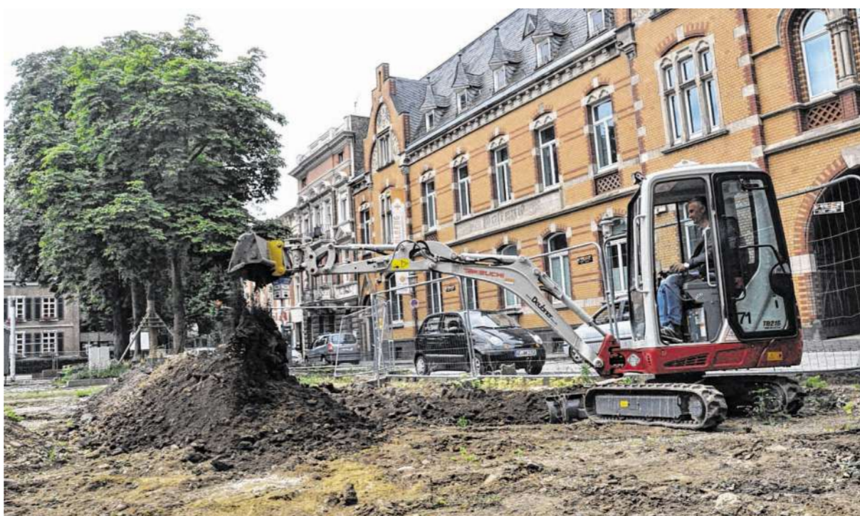
Erste kleine Baggerbisse: Die Firma DS Projektbau trägt den belasteten Boden ab, an der Stelle, wo die künftige Gastronomie des Kupferpavillons entstehen soll. Foto: S.-L. Gombert
