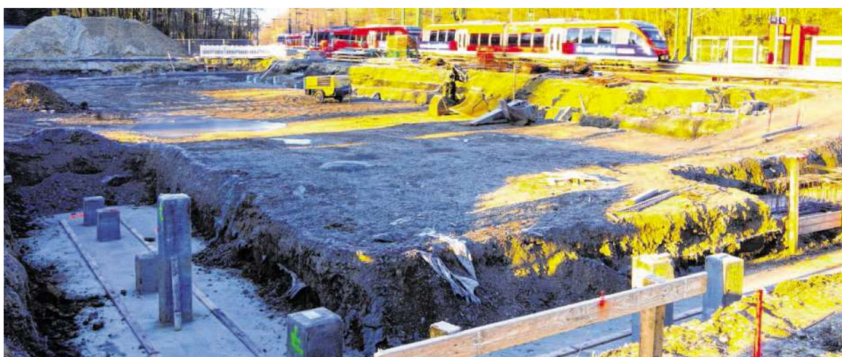
Drei Vorzeigeprojekte, die in diesem Frühjahr eingeweiht werden können: Die Umgestaltung von Kaiserplatz sowie Frankental mit Bastinsweiher und das neue Parkhaus am Hauptbahnhof. Fotos: J. Lange
