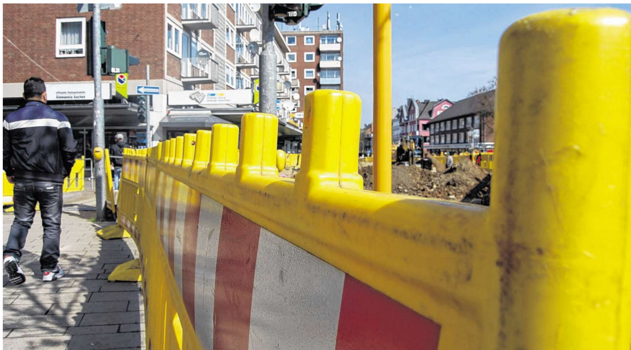
Nicht nur für Autofahrer ist die Baustelle am Bastinsweiher eine Achterbahnfahrt auf Asphalt, sondern auch für die Fußgänger. Einige Geschäfte lassen sich nämlich nur noch zu Fuß erreichen. Für Händler und Kunden ist das zum Teil sehr umständlich. Foto: L. Beemelmans
