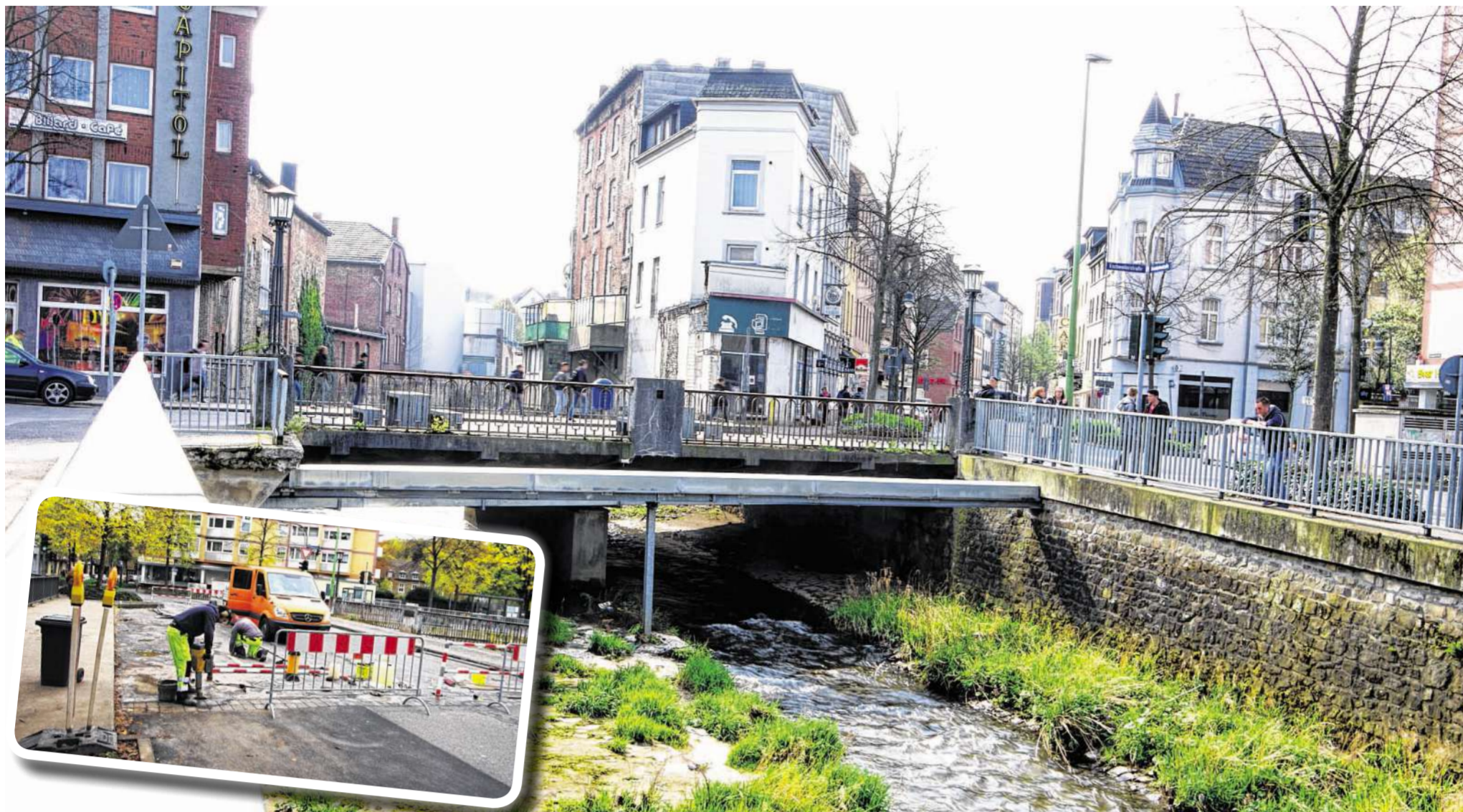
Friedrich plätschert die Vicht in diesen Tagen unter der Heinrich-Heimes-Brücke dahin. Bei Hochwasser verwandelt sich der Bach in reißende Fluten. Beim letzten großen Hochwasser im Sommer 2014 fehlte nur eine Handbreite bis zum Überlaufen. Seit dem 8. November 2012 ist die Brücke für den Kraftverkehr komplett gesperrt (kl. Bild). Foto: J. Lange
