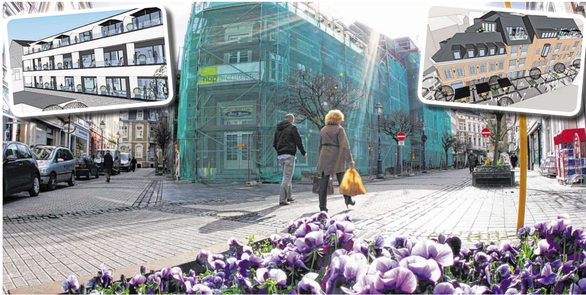
Wie ein Schiff am Kai von Sonntalstraße und Steinweg: Im Herbst soll das neue „Rathaus-Carré“ bezugsfertig sein. 39 Wohnungen sowie Büroraum entstehen. Noch laufen die Verhandlungen über die Vermietung der Gewerbeeinheit im Parterre. Nachdem „Action“ abgesprungen ist, ist die Rede von klassischem Einzelhandel. Fotos: Lange; Visualisierungen: nbp
