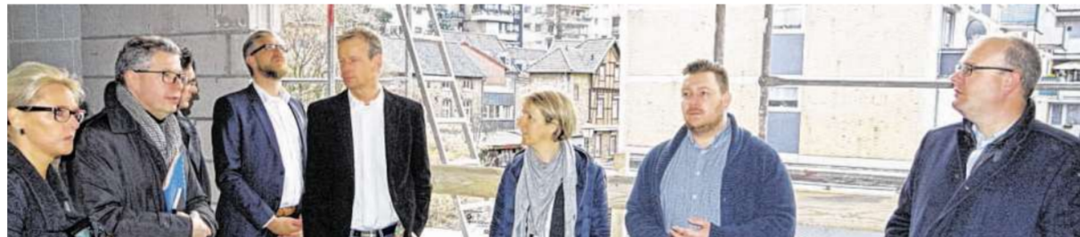
Ein Stück Altstadt wird sichtbar: Die bisher geschlossene Fassade zum Hof an der Seite der Enkereistraße lässt Investor Fred Pfenning (4.v.r.) aufschneiden. Eine Fensterfront für die Wohnungen entsteht.
