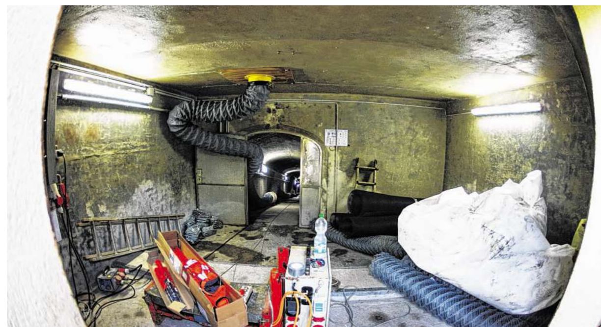
Derzeit hat die Enwor Instandhaltungsarbeiten am Brunnen Schleicherstollen an Nachtigällchen beauftragt. Als zweiter Brunnen ist der Mariaschacht nahe Breinigerberg in Betrieb. Foto: J. Lange
