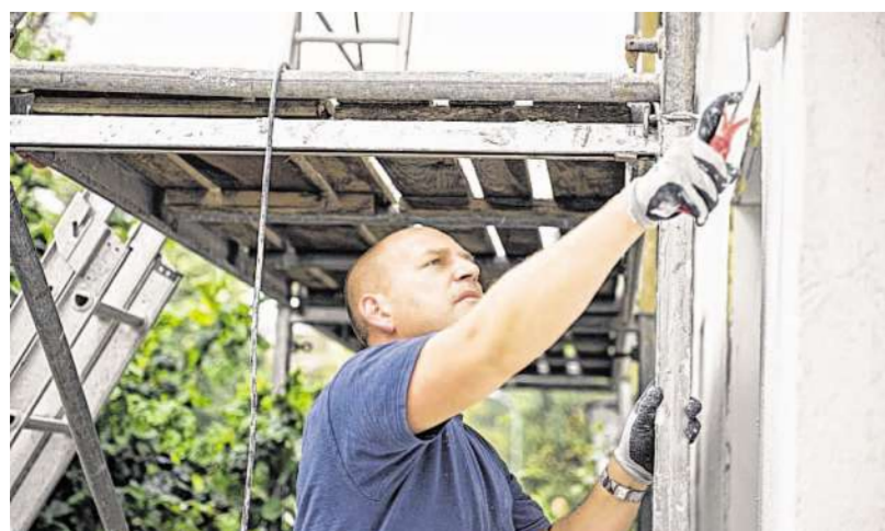
Zur Sanierung der Fassaden im Stolberger Zentrum gibt es Zuschüsse. Die ersten Anträge sind schon eingegangen. Foto: stock & people
