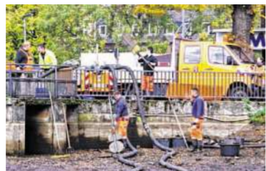
► Verkehrsschilder und Baken: Das Technische Betriebsamt kann seine Bestände mit Verlorenem wieder auffüllen.
